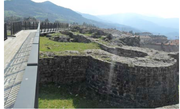
Castello di Berceto: veduta della base di una delle torri e della passerella in legno.
